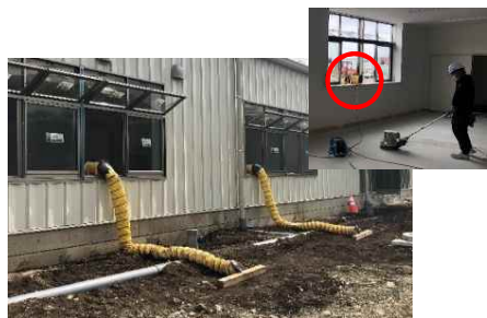
送風機を稼働し、埃を外部へ排出
