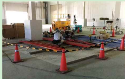
工事エリアの区画を設定して作業
